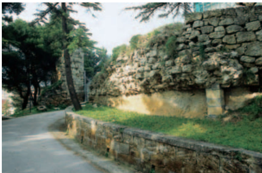
Abb. 2. Torre di Federico, Ringmauer und Haupttor (Foto: Verf., 1999).
