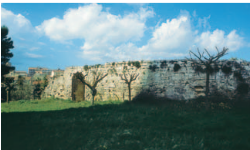
Abb. 8. Castello di Lagopesole, Ringmauer mit Ausfallpforte (Foto: Verf., 1999).
