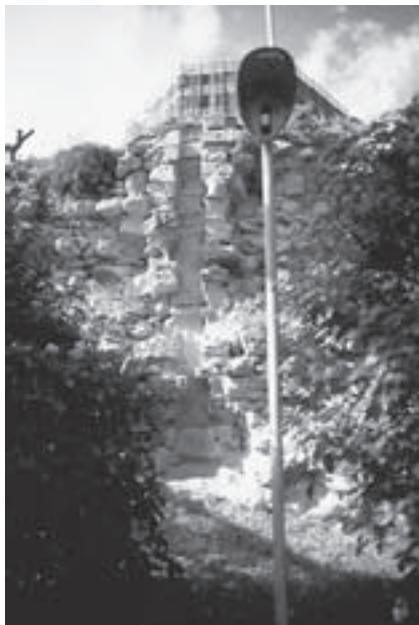
Abb. 10. Öffnungen unterhalb der Ausfallpforte, die oben angeschnitten ist (Foto: Verf., 1999).
