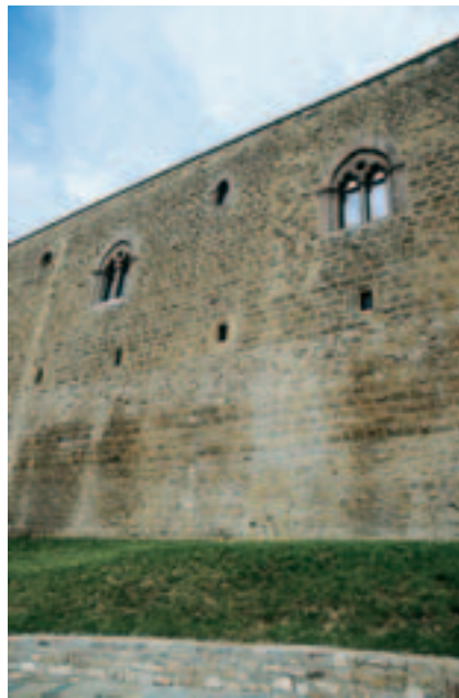
Abb. 7. Ringmauer an der Eingangsseite (Foto: Verf., 1996).
