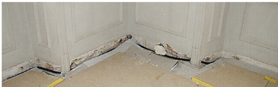
Abb. 28. und 29. Die Kabeltrasse am Fußboden und das kaum sichtbare Heizkabel auf dem Stuckgesims.
