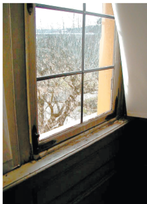
Abb. 8. und 9. Bei kalten Außentemperaturen kondensierte an den Einfachfenstern die überschüssige Raumluftfeuchte. Das verminderte noch größere Durchfeuchtungsschäden in kritischen Klimasituationen.
