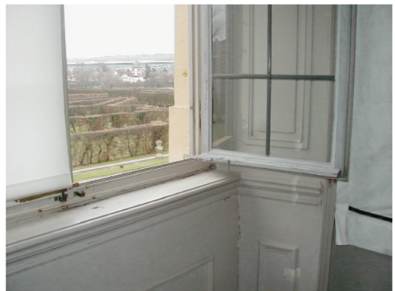
Abb. 8. und 9. Bei kalten Außentemperaturen kondensierte an den Einfachfenstern die überschüssige Raumluftfeuchte. Das verminderte noch größere Durchfeuchtungsschäden in kritischen Klimasituationen.
