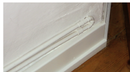
Abb. 23. bis 25. Die offen verlegte Sockeltemperierung im Bau (links) und nach Maßnahmenabschluss (rechts) für erhöhten Wärmebedarf ergänzt mit Strahlplatten.
