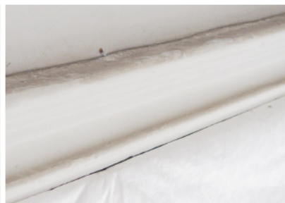
Abb. 28. und 29. Die Kabeltrasse am Fußboden und das kaum sichtbare Heizkabel auf dem Stuckgesims.
