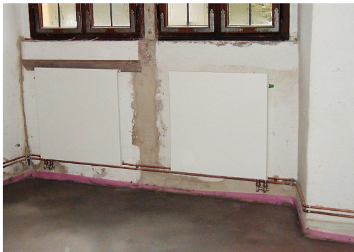
Abb. 23. bis 25. Die offen verlegte Sockeltemperierung im Bau (links) und nach Maßnahmenabschluss (rechts) für erhöhten Wärmebedarf ergänzt mit Strahlplatten.
