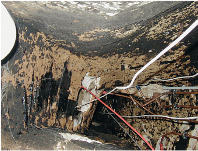
Abb. 18. Die Versorgungsleitungen durch die Geschosse konnten durch vorhandene Schornsteine und Schächte „gefädelt“ werden.
