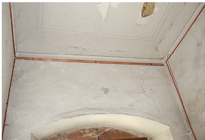
Abb. 26. und 27. Die Deckenkreisläufe im Bau (links) und nach der Fertigstellung (rechts).
