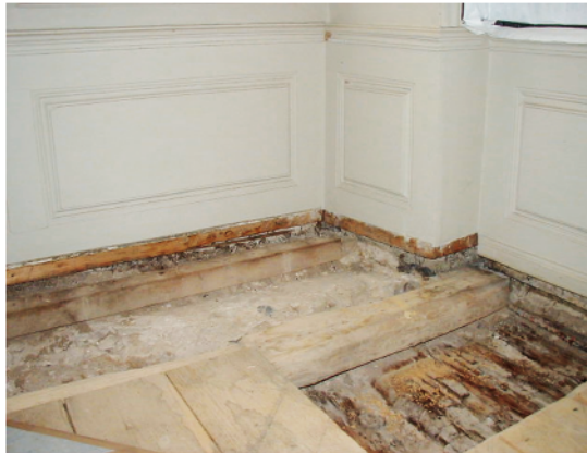
Abb. 6. und 7. Auch unter den Holzdielen und dem Tafelparkett im Obergeschoss vermorschte die Holzdeckenkonstruktion durch Kondensatauffeuchtung und folgenden Pilzbefall. In den kritischen Eckbereichen im Obergeschoss waren die wertvollen Papiertapeten mit Schimmel befallen – ebenfalls durch eine dauerhaft überhöhte Kondensataufnahme.
