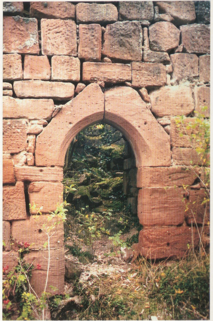
Abb. 8. Alt-Windstein. Nördliche Oberburg. Turmzugang an der Nordseite (Foto: Verf.).
