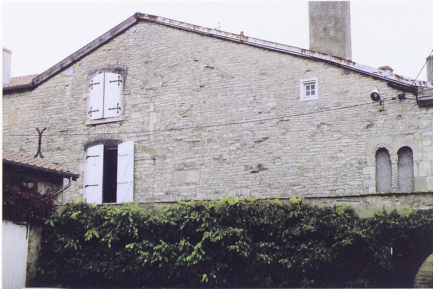
Abb. 7. „Altes Hospiz“ (11. Jahrhundert): Seitenwand des Hauses 1-3, rue de la Chanaise. Das Beispiel zeigt, von der Straße aus sichtbar, zwei romanische Bauphasen, zu denen unterschiedliche Hausformen und stilistisch unterschiedlich ausgeführte Öffnungen und Baudekor gehören. Solche Unterschiede wurden bisher dem Erscheinungsbild des städtischen Reihenhauses als primärer Steinbauphase untergeordnet (Foto: Verf.).
