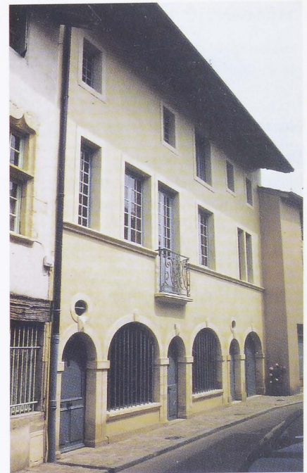
Abb. 1. „Bürgerhaus“ von 1091: Straßenfassade des Hauses 20, rue du Merle von 1596. Die wesentlichen Elemente dieses leichten Renaissanceentwurfs sind schon bei den romanischen Reihenhäusern vorhanden: Tür und Arkade (hier gereiht), Fenster des Hauptgeschosses auf durchgehendem Gesims, Kniestock, Dachüberstand (Foto: Verf.).
