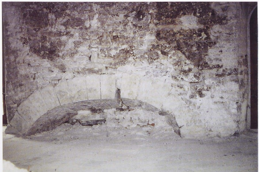
Abb. 13. „Vogtsbau“ (11. Jahrhundert): Saalgeschoss. Ins heutige zweite Obergeschoss durchstoßender Rundbogen des großen Saalfensters. Er ist von hammerrechtem Mauerwerk mit romanischem pietra-rasa -Putz ohne stilatura umgeben (Foto: Verf.).
