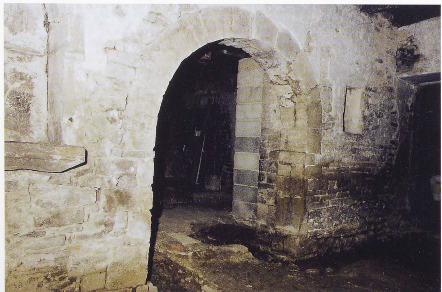
Abb. 2. „Bürgerhaus“ von 1091: Erdgeschoss. Innenliegende Fassade des romanischen Kernbaus mit Rundbogentor. Das Foto zeigt den Zustand während der Grabung 1997. Die Beckennische links und der Durchbruch rechts vom Tor sind sekundär (Foto: Verf.).
