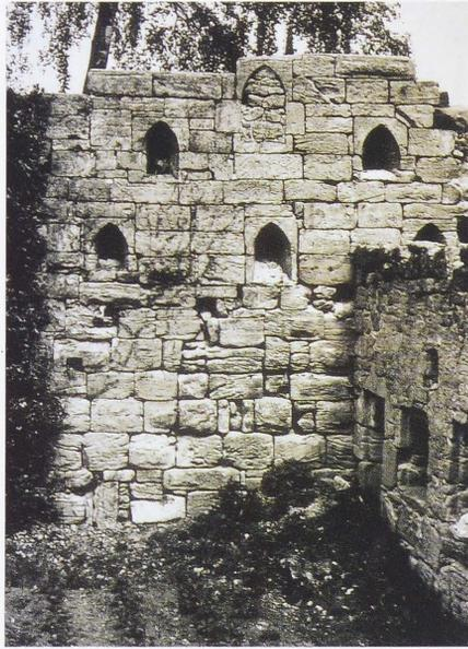
Abb. 12. Südwand. Feldansicht (von Süden). Bemerkenswert sind die sechs Trichterfenster der pyramidenförmigen Kleinfenstergruppe. Die Wand wurde im 14. Jahrhundert aus Spolien errichtet. Rechts der hussitenzeitliche Südtorbau (Foto: Uwe Gaasch, 1994).
