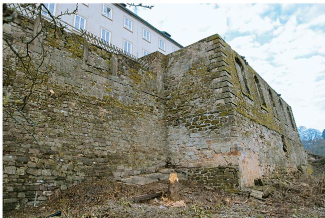
Abb. 11. Blieskastel, der erhaltene Rest der Fassade des Schlosses bedarf dringend der Sicherung, hier der Mittelrisalit des Hauptbaues (Foto: Verf.).
