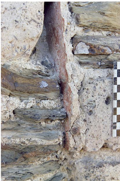
Abb. 6. Romanischer Palas, Nordfassade, Erstes Obergeschoss. An der zugesetzten romanischen Öffnung finden sich in der Laibung noch Reste des ursprünglichen Putzmörtels mit einer roten Farbfassung (Foto: Ferdinand Lawen, 2006).
