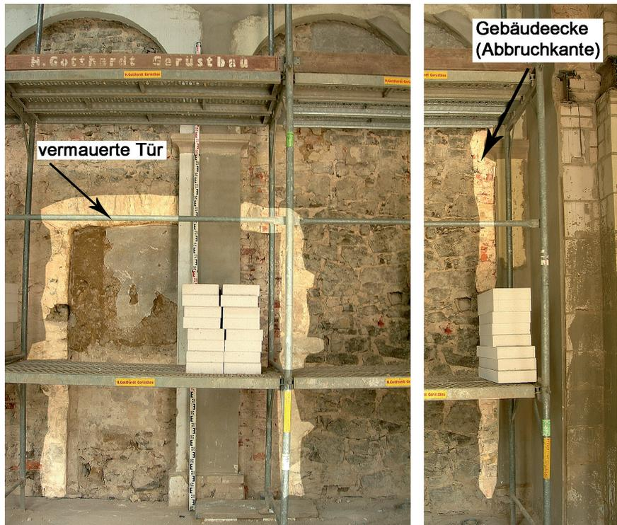
Abb. 9. Wand- und Gewölbefsanierung im Kreuzgang (Mai 2007). Im oberen Foto der Blick von Süden auf die Außenwand des südlichen Kreuzgangflügels, hell hervorgehoben sind die vermauerte Tür mit Gewänden aus Sandsteinquadern und die Abbruchkante der älteren Gebäudeecke. Die unteren Bilder zeigen analog dazu den Blick von der Kreuzganginnenseite auf dieselbe Stelle der Außenwand. Hier zeichnet sich die aus Quadern gesetzte Gebäudeecke besonders deutlich ab.
