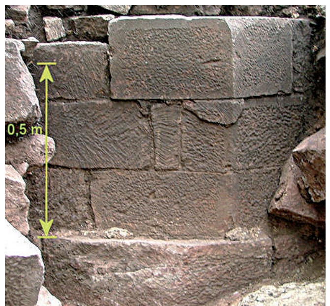
Abb. 6. (rechts) Die in drei Lagen erhaltene Maueraußenschale des Wohnturmes (Südwestecke). Darunter die abgebrochene Ecke des Sockels.
