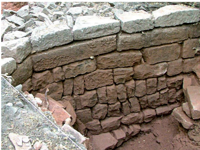
Abb. 5. Innenseite des Ringmauerfundamentes.
