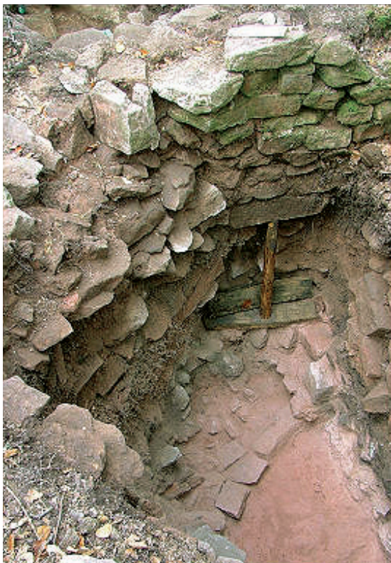
Abb. 7. Die Reste der Mauerinnenschale und das freiliegende Füllmauerwerk. Im unteren Drittel der Mauer ist auch das Füllmauerwerk ausgebrochen. Die sekundäre Sandverfüllung der Ausbrüche ist nicht vollständig ausgenommen.
