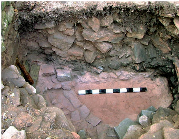
Abb. 7. Die Reste der Mauerinnenschale und das freiliegende Füllmauerwerk. Im unteren Drittel der Mauer ist auch das Füllmauerwerk ausgebrochen. Die sekundäre Sandverfüllung der Ausbrüche ist nicht vollständig ausgenommen.
