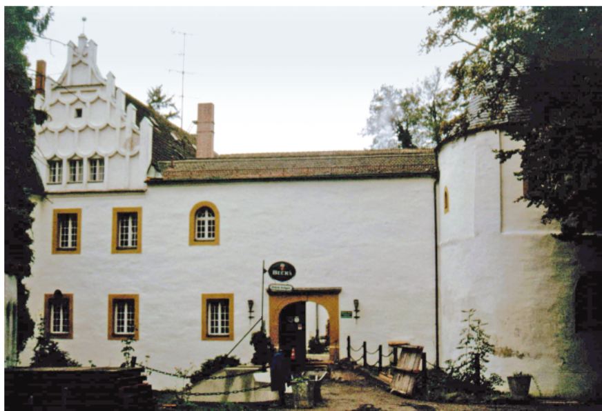
Abb. 2. Haupteingang mit Brücke. Die Baugrube liegt vor dem linken Torflügel (Foto: Verf.).
