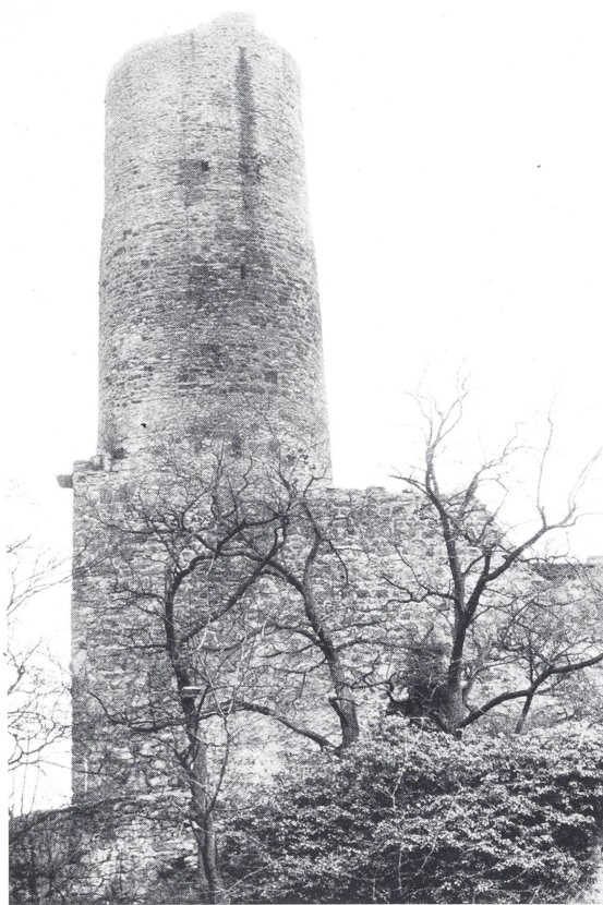
Abb. 5. Südecke mit Bergfried: Die Verjüngung der sekundären Aufstockung und die steinernen Konsolen des Wehgangs sind deutlich zu erkennen (Foto: Th. Biller).
