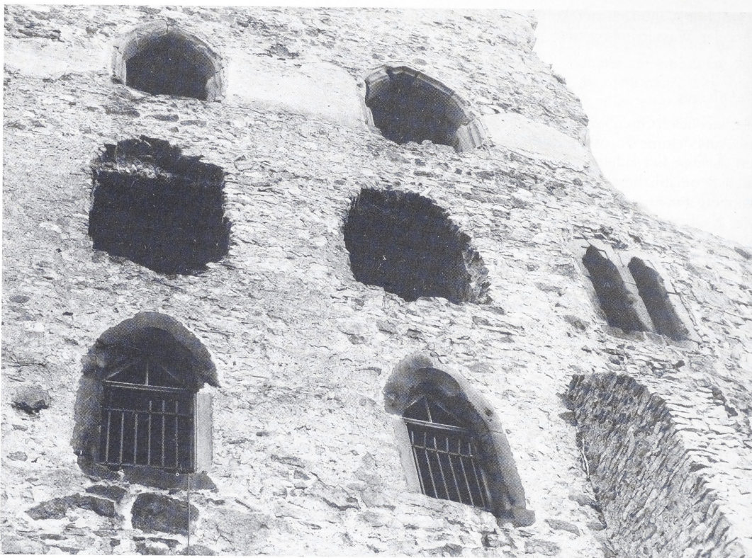
Abb. 11. Ehemals doppeltes Spitzbogenfenster des 1. Obergeschosses und das zusammengesetzte Fenster des 2. Obergeschosses mit sekundärem Falz (Foto: Th. Biller).
