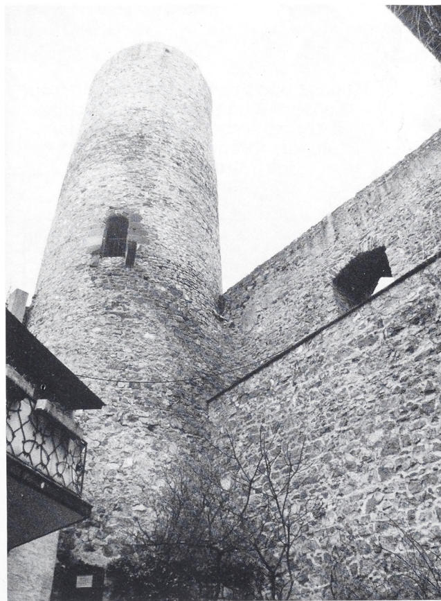
Abb. 6. Bergfried mit der anschließenden Südwand des Wohnbaus. Die Höhe des Bergfried-Eingangs stimmt mit der Ringmauer überein. Auch hier ist die Verjüngung des oberen Bergfrieddrittels deutlich sichtbar (Foto: Th. Biller).
