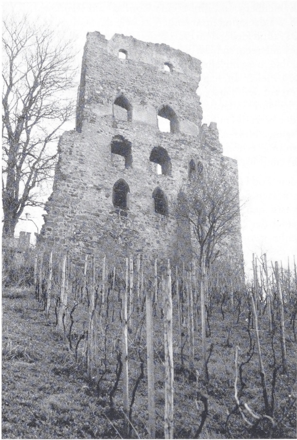
Abb. 3. Giebelwand des Wohnbaus, links der Ansatz der talseitigen Ringmauer mit steinernem Wehrgang (Foto: Th. Biller).
