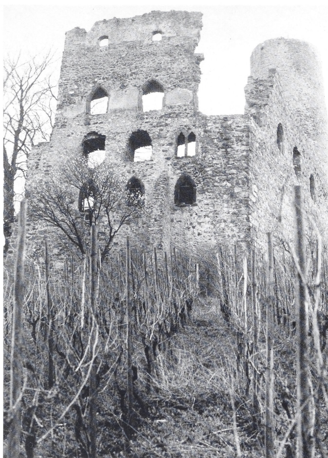
Abb. 8. Giebelwand des Wohnbaues mit den Fensterresten des 1. bis 3. Obergeschosses und den Wehrfenstern der schmalen Brüstungsmauer. Links ist der Ansatz der Ringmauer zu erkennen (Foto: Th. Biller).
