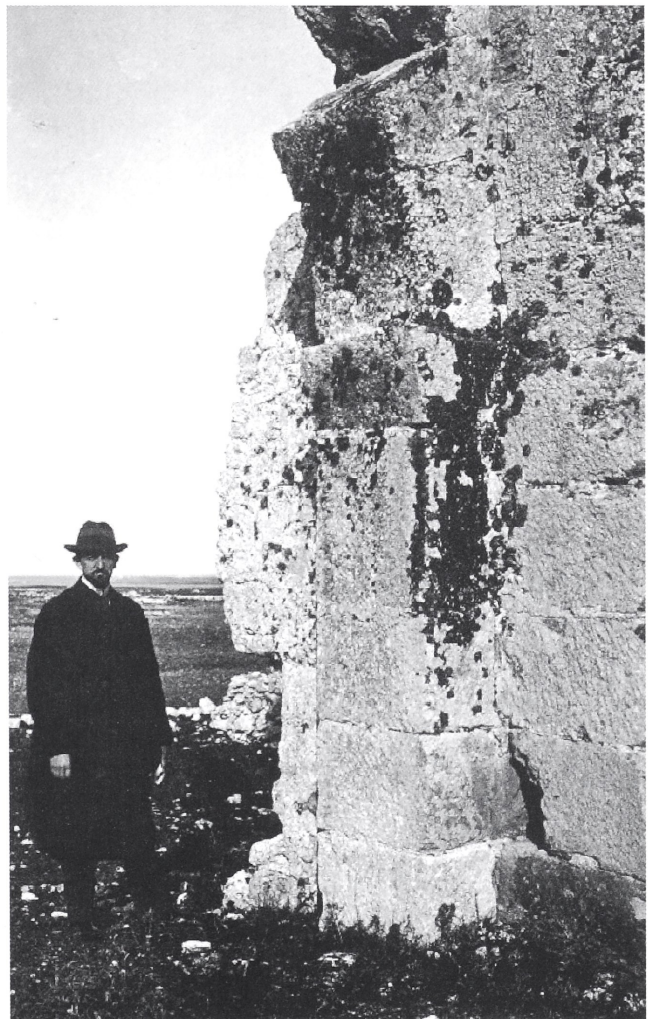
Abb. 1. Centoporte bei Guerdignano, Terra d' Otranto, Detail der Fassade mit Arthur Haseloff, 1906
