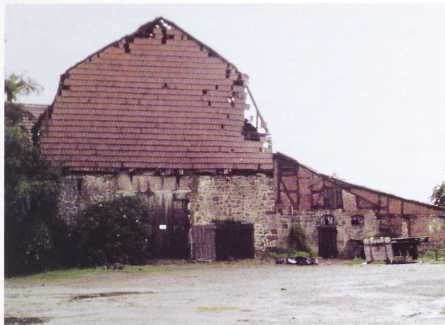
Abb. 6. Burg Binsförth. Ansicht der ehemaligen Scheune von der Hofseite vor dem Dacheinsturz 1984 (Foto: Verf.).
