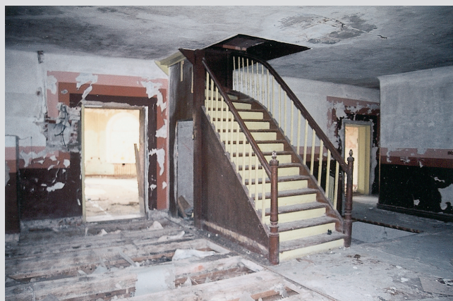
Abb. 3. Obergeschoss mit Treppe zum Dachstuhl (Foto: Verf.).
