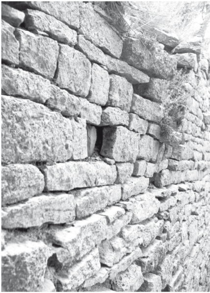
Abb. 24. Burg Brauneck, Schildmauer, Innenseite, freistehende und dadurch absturzgefährdete Mauerschale, Zustand 1982.
