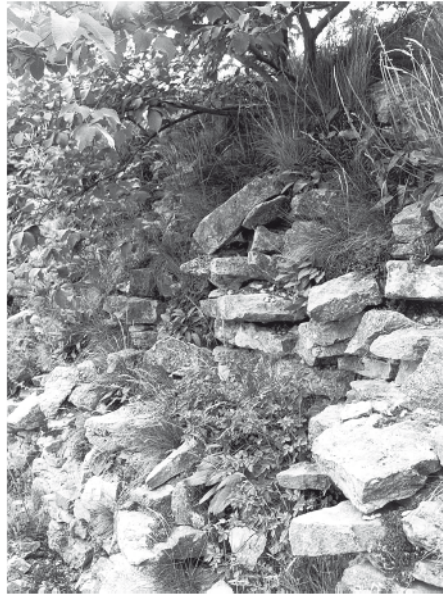
Abb. 24. Burg Brauneck, Schildmauer, Innenseite, freistehende und dadurch absturzgefährdete Mauerschale, Zustand 1982.
