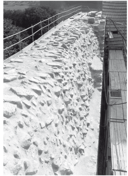
Abb. 24. Burg Brauneck, Schildmauer, Innenseite, freistehende und dadurch absturzgefährdete Mauerschale, Zustand 1982.
