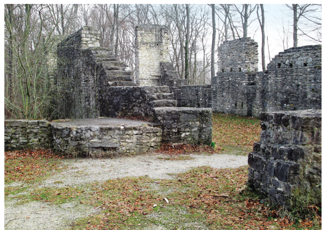
Abb. 20. Burg Melchingen, Haus III, Blickrichtung gegen Norden (Foto: Verf., 2009).
