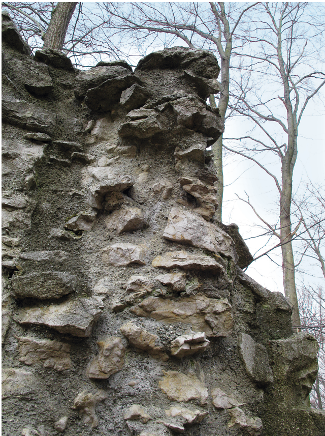
Abb. 21. Burg Melchingen, Detail an der Westmauer, Beispiel für „Sicherung wie vorgefunden“ unter Verwendung von Spritzbeton, ausgeführt 1982 (Foto: Verf., 2009).
