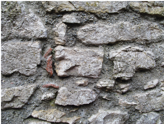
Abb. 23. Burg Melchingen, Detail an der Westmauer, neuer Fugenschluss betonttieferliegend, unter Verwendung von Spritzbeton ausgeführt 1982 (Foto: Verf., 2009).
