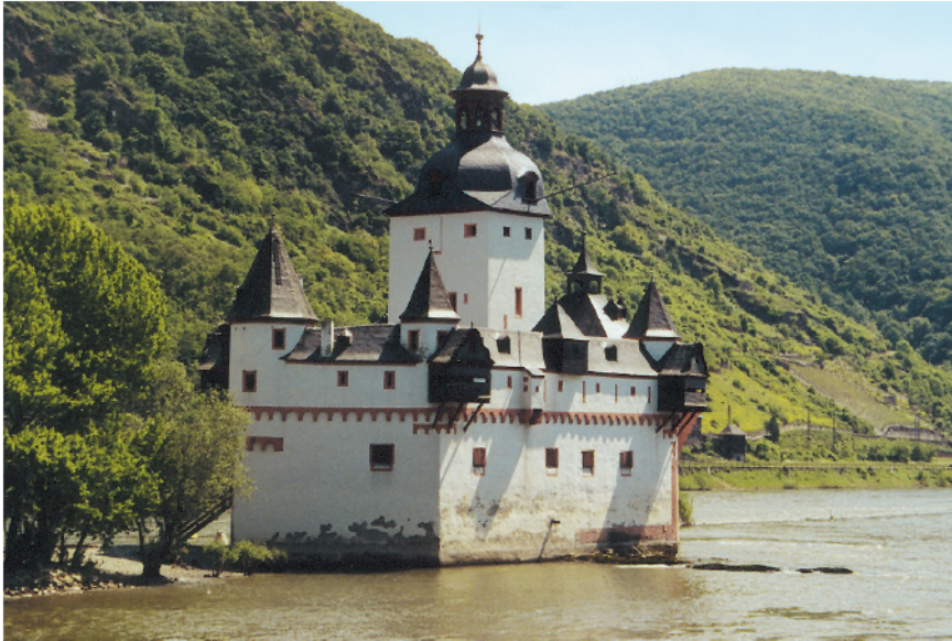
Abb. 76. Pfalzgrafenstein mit Putzschäden (Foto: IFS, 1999).
