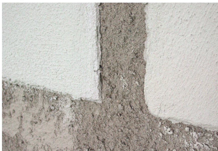
Abb. 79. Musterfläche des Reparaturputzsystems (Foto: Verf.).
