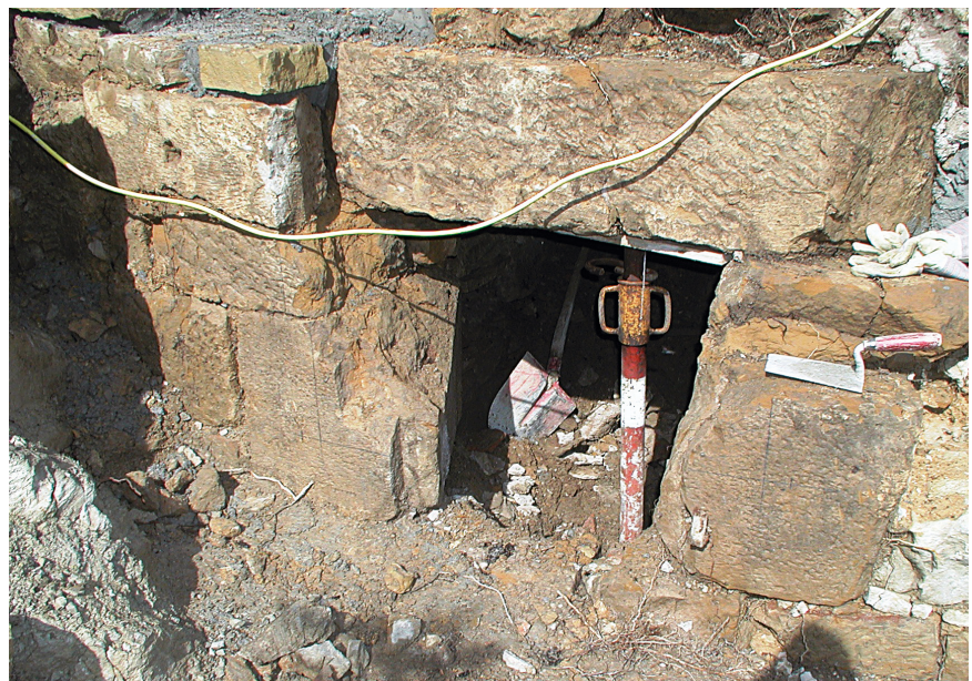
Abb. 27. Burg Rechberg, Schießscharte (7.5.07) am „Turmkeller“ zu Beginn der baulichen Sicherung. Man beachte rechts unten neben der Öffnung den Stützkloben für den ehemaligen Verschluss (Foto: Verf.).
