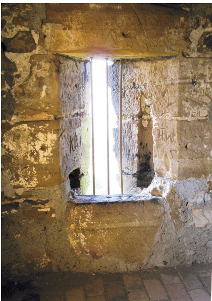
Abb. 21. Burg Rechberg, Torhaus, Innenseite der Scharte 1.2.15 mit nachträglich herausgespitztem Steckloch und Streifschlitz für das Prellholz (Foto: Verf.).
