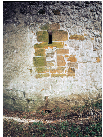
Abb. 26. Burg Rechberg, Schießscharte (6.5.05) in einer Sonderform an der „Turmscheune“, siehe darunter nach Geländeoberhöhe die Öffnung einer weiteren Scharte (Foto: Verf.).
