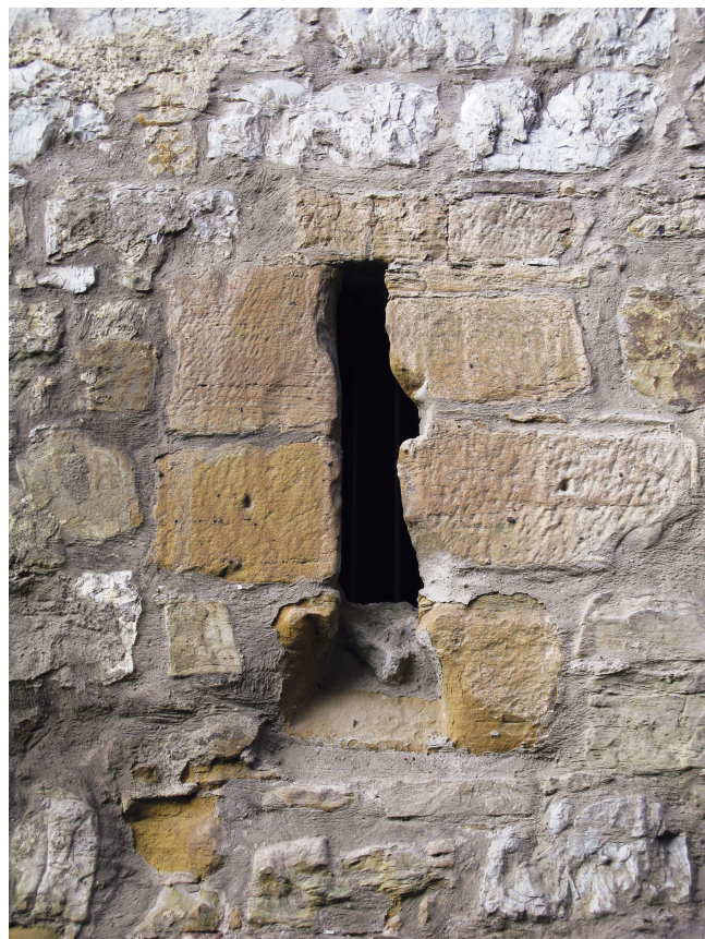
Abb. 15. Burg Rechberg, Torhaus, Scharte 1.2.01, später von innen her teilweise zugemauert wegen Nutzung der Schießkammer als Gefängniszelle (Foto: Verf.).
