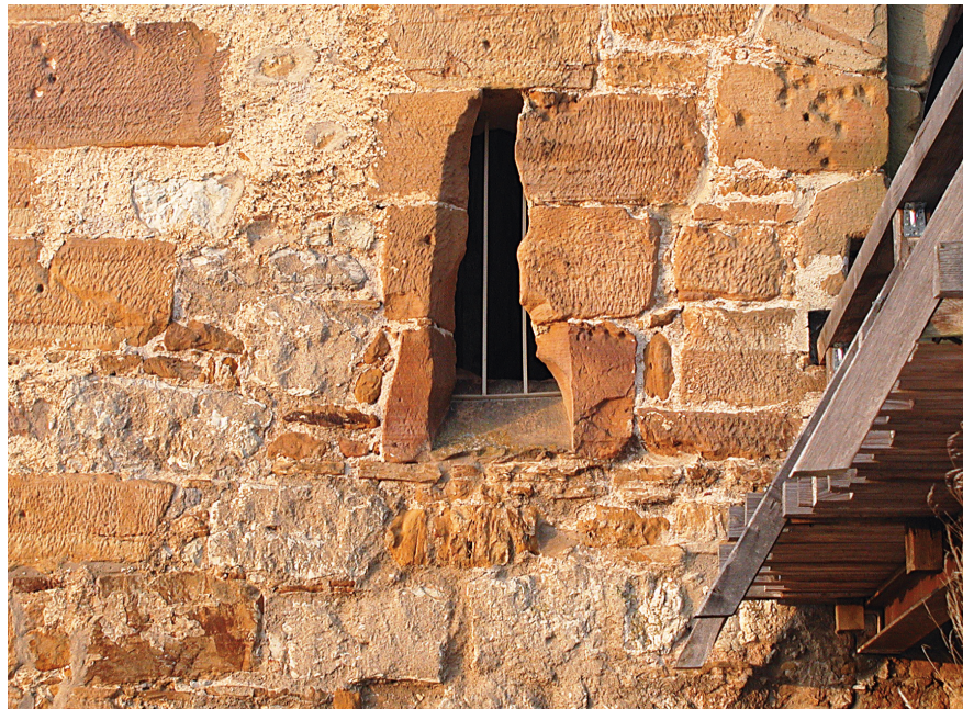
Abb. 20. Burg Rechberg, Torhaus, Scharte 1.2.11 mit der auffälligen und einseitigen späteren Verbreiterung des Schartenschlitzes (Foto: Verf.).
