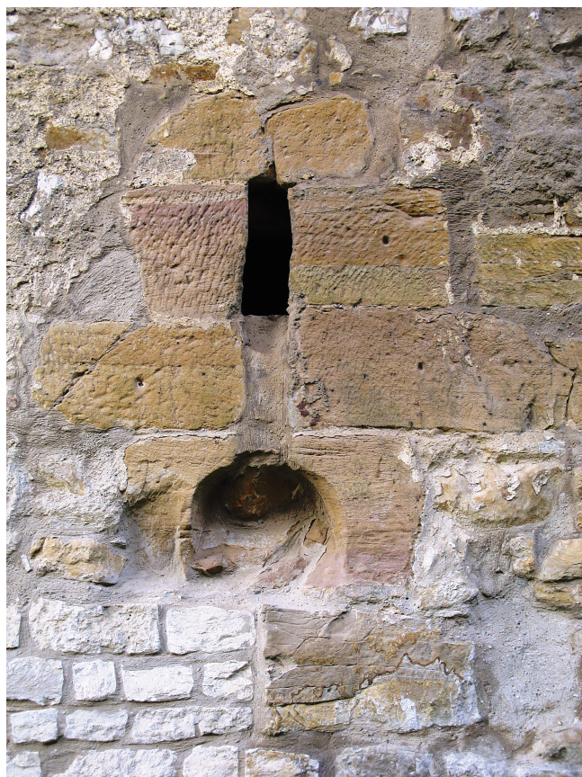
Abb. 15. Burg Rechberg, Torhaus, Scharte 1.2.01, später von innen her teilweise zugemauert wegen Nutzung der Schießkammer als Gefängniszelle (Foto: Verf.).
