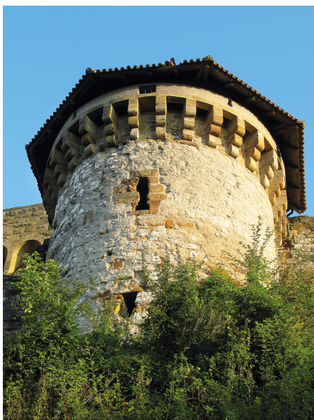
Abb. 9. Burg Rechberg, der Maschikuliturm (Bauteil Nr. 3) vom äußeren Zwinger aus (Foto: Verf.).
