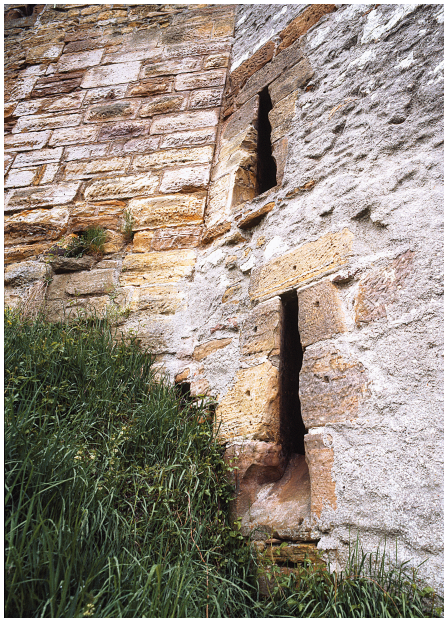
Abb. 7. Burg Rechberg, Baufuge zwischen Torhaus (Bauteil 1) rechts im Bild und Innenzwinger „a“ (Bauteil 2) links im Bild. Die beiden Steigbügelscharten (unten 1.2.08 / oben 1.2.13) sind zur Verbesserung des Schussfeldes nachträglich verbreitert worden. Die rechts im Bild erkennbaren grauen Putzflächen stammen von „Sanierungen“ des Vorbesitzers (Foto: Verf.).
