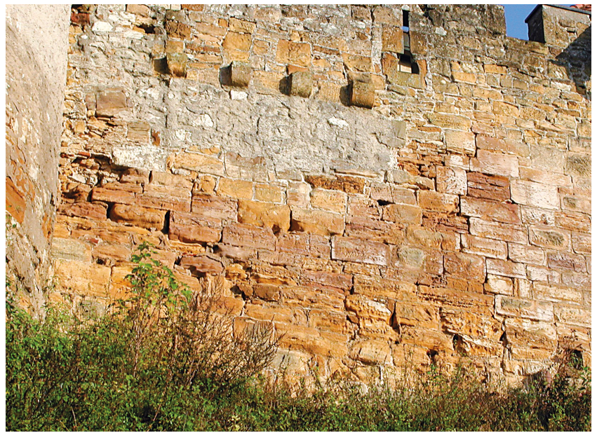
Abb. 7. Burg Rechberg, Baufuge zwischen Torhaus (Bauteil 1) rechts im Bild und Innenzwinger „a“ (Bauteil 2) links im Bild. Die beiden Steigbügelscharten (unten 1.2.08 / oben 1.2.13) sind zur Verbesserung des Schussfeldes nachträglich verbreitert worden. Die rechts im Bild erkennbaren grauen Putzflächen stammen von „Sanierungen“ des Vorbesitzers (Foto: Verf.).
