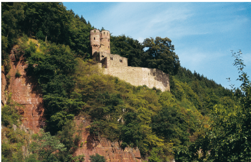
Abb. 2. Die Ansicht der Burg Schadeck aus dem Neckartal verdeutlicht deren zwar pittoreske, aber fortifikatorisch nicht besonders günstige Lage im Steilhang über dem Fluss. Die Felsabbrüche links im Bild sind das Werk neuzeitlicher Steinbrüche (Foto: Verf., ca. 1981).
