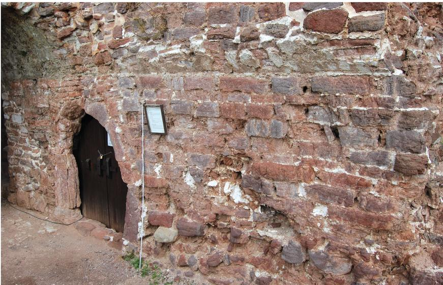
Abb. 8 Burgruine Hohnstein, Wohnturm, Südmauer mit präzise versetztem Kleinquaderwerk von Südosten (Foto: Verf., Aug. 2009).
