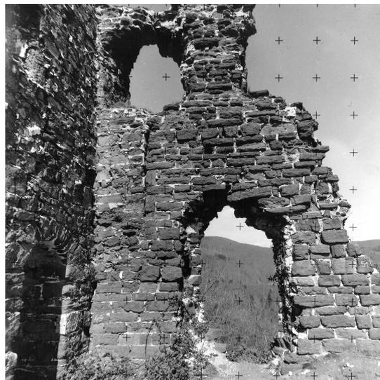
Abb. 5 Burgruine Hohnstein, Wohnturm, Nordmauer (außen) mit Spuren eines zugesetzten Aborterkers (?) (Foto: Verf., Sept. 2009).
