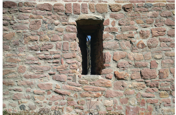
Abb. 9. Ruine Auersburg, Schlitzfenster in der Nordostmauer, Hofseite (Foto: Annina Hilfenhaus, 2009).
