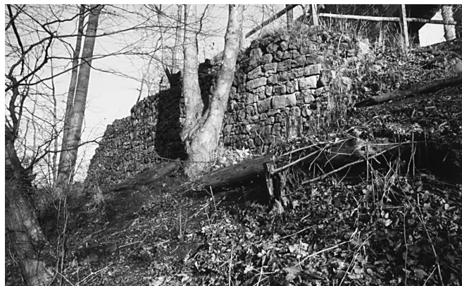
Abb. 13. Ruine Auersburg, Rest einer Vormauer unterhalb des Kernburgtores, Ansicht von Südwesten (Foto: Verf., 2007).
