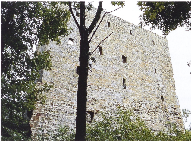
Abb. 1. Burgruine Straufhain. Von der Westseite ist die Turmartigkeit des Wohnbaus am besten erkennbar. Im Keller die ausgebrochene Scharte, darüber Schlitz- und Rechteckfenster, teilweise durch Vermauerung verändert (Foto: Verf., 2000).
