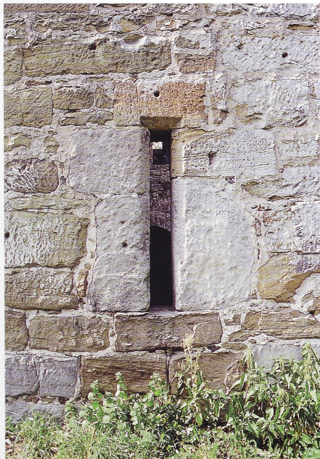
Abb. 3. Burgruine Straufhain. Schlitzscharte südlich der Pforte mit auslaufender Fase im Gewände (Foto: Verf., 2000).
