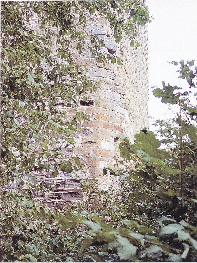
Abb. 11. Burgruine Straufhain. Reste der Umfassungsmauer an der Südwestecke des Wohnbaus; die Verzahnung ist erkennbar (Foto: Verf., 2000).
