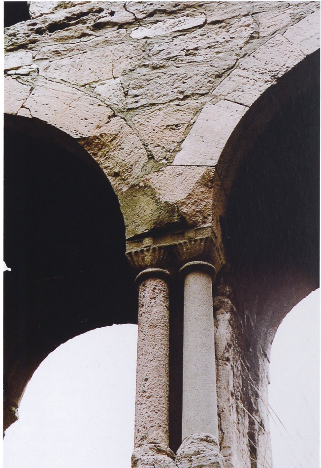
Abb. 2. Fenster im Palas der Lobdeburg (Foto: Kulturamt Jena).
