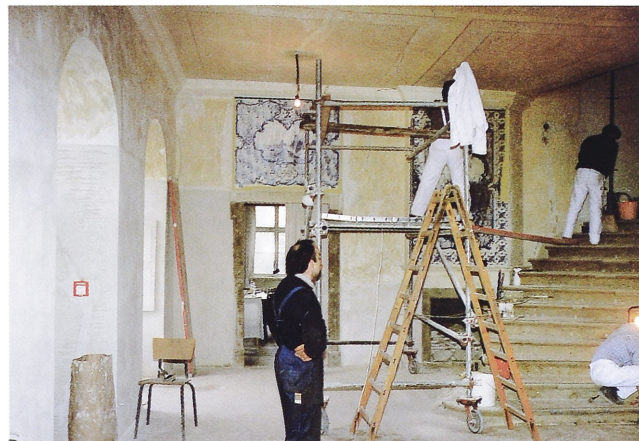
Abb. 3. Restaurierungsmaßnahmen im Foyer von Schloß Belvedere, Weimar (Foto: Krause, 1991).
