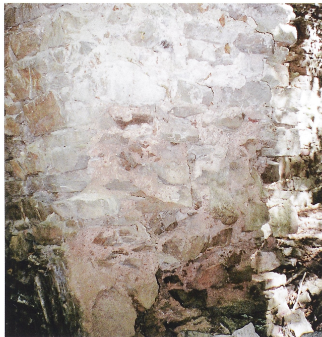
Abb. 1. Burgruine Suitbertstein. Schnitt der Mauer in der Bresche (Foto: Verf., 1998).
