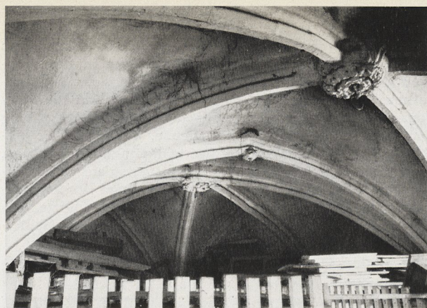
Abb. 4 Ehem. Dorotheenkappelle im westl. Turm Hinter Grieb 8, den Gravenreutern gehörig. Im XVI. Jh. wie alle Hauskapellen profaniert, seither Abstellraum. Reicher Bau-dekor Anfang XIV. Jh.
