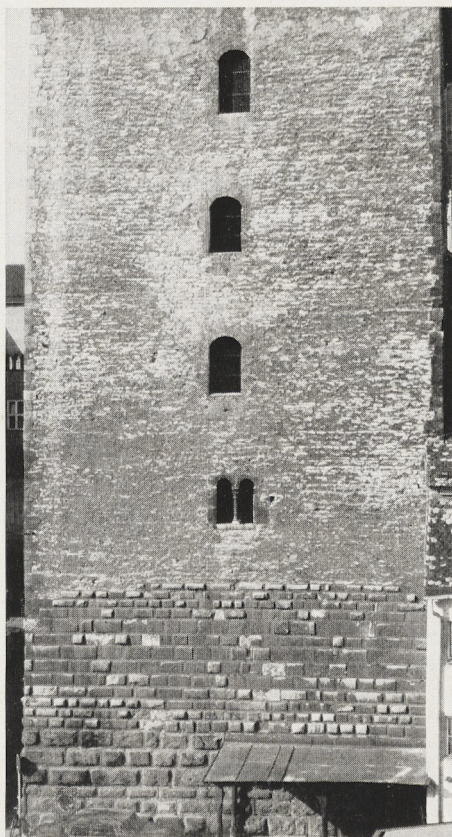
Abb. 5 Römerturm. Ost. Frühes XIII. Jh., evtl. mit älteren Teilen. Sockelgeschoß Granitquader, dann Buckelquader aus Kalkstein, Obergeschosse Bruchsteine mit Eckquadem. Im 1. Obergeschoß (wie ursprünglich auch darüber) Doppelarkade mit Rotmarmorsäulchen, Innenaussicht mit Kamin
