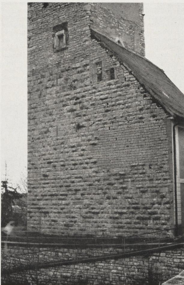
Abb. 6 Hirschberg, romanischer Teil des Bergfrieds und Rest der Schildmauer. An der Westseite des Turmes sind die ins erste und zweite Obergeschoß führenden Lichtschlitze zu erkennen. Der rechts in gleicher Flucht anschließende Rest der Schildmauer ist durch den zweimaligen Wechsel der Mauer-technik bemerkenswert
