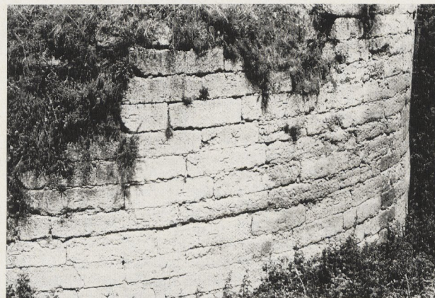
Abb. 23. Coucy-le-Château. Mauerwerk mit Steinmetzzeichen am Südost-Turm. 1967
