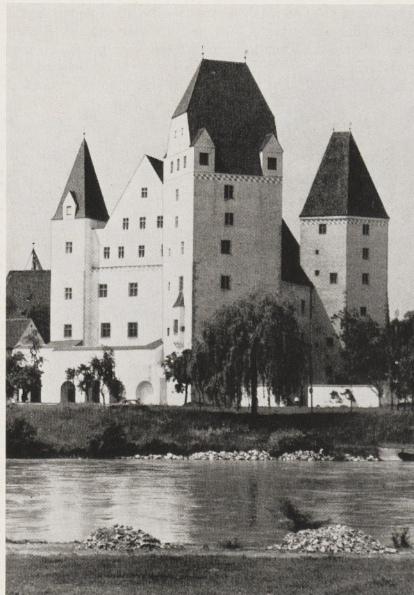
Abb. 5. Ingolstadt, Neues Schloß (Anfang XV. Jh.). Der mehrfach veränderte, zuletzt im 2. Weltkrieg stark beschädigte Bau wurde in den letzten Jahren wieder in die ursprüngliche Form gebracht. Aufnahme 1970
