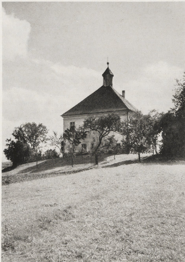
Abb. 19. Das Schlößchen Loibersdorf bei Wasserburg am Inn ist ein typisches Beispiel eines kleinen oberbayerischen Barockschlosses mit einfachem Zelt- oder Walmdach. Diese Form kam bei sehr vielen Neubauten des 17. Jh. und 18. Jh. zur Anwendung
