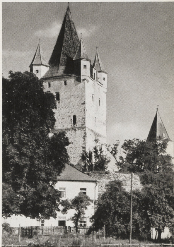
Abb. 7. Schloß Haag bei Wasserburg am Inn. Der Bergfried im unteren Teil um 1200, oberer Teil gegen 1500. 1804 wurde das Schloß bis auf den Bergfried und den Torturm abgebrochen
