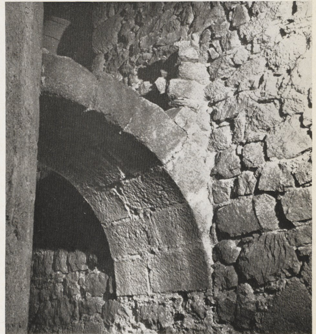
Abb. 10. Ortenburg, Strebobogen zwischen dem Bergfried und dem Mantel, Westseite
