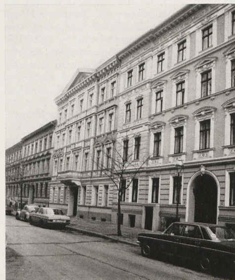
Abb. 7. Alte Mietshäuser in der Charlottenburger Christstraße werden im Stil der Jahrhundertwende wiederhergestellt
