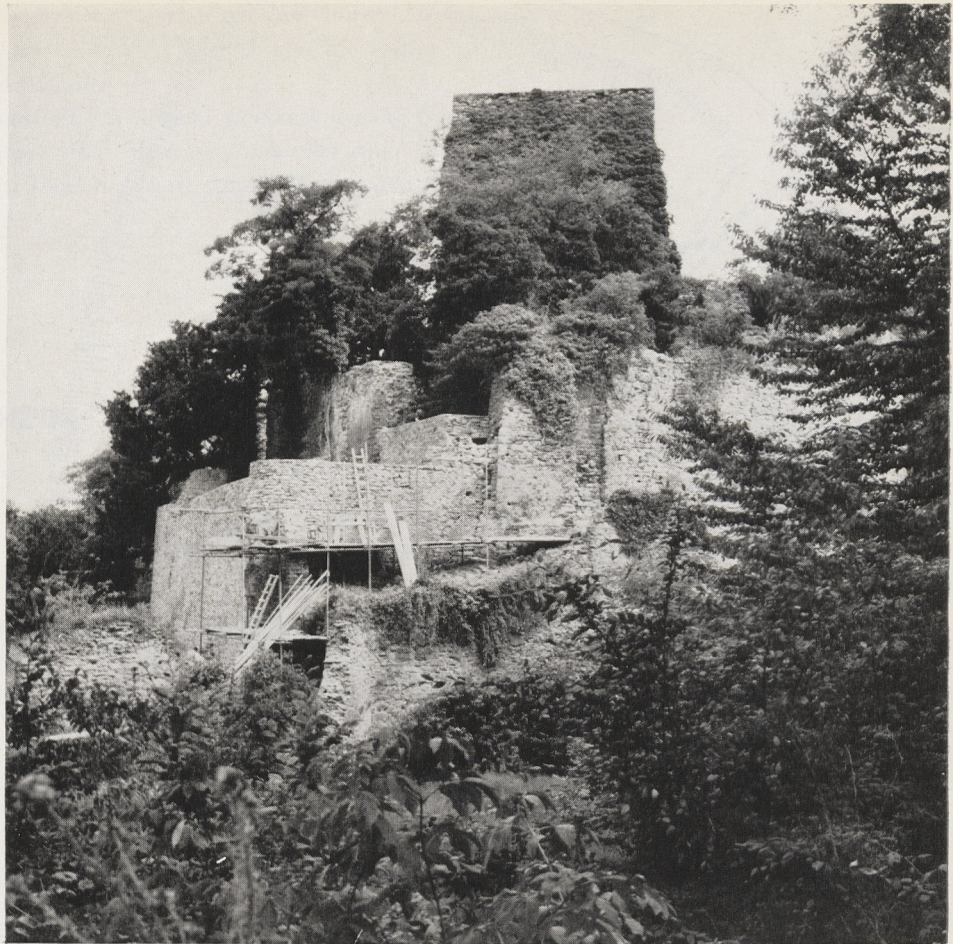
Abb. 7. Burgruine Hardtburg. Blick von Nordwesten auf Bergfried und Kernburg während der Instandsetzungsarbeiten
