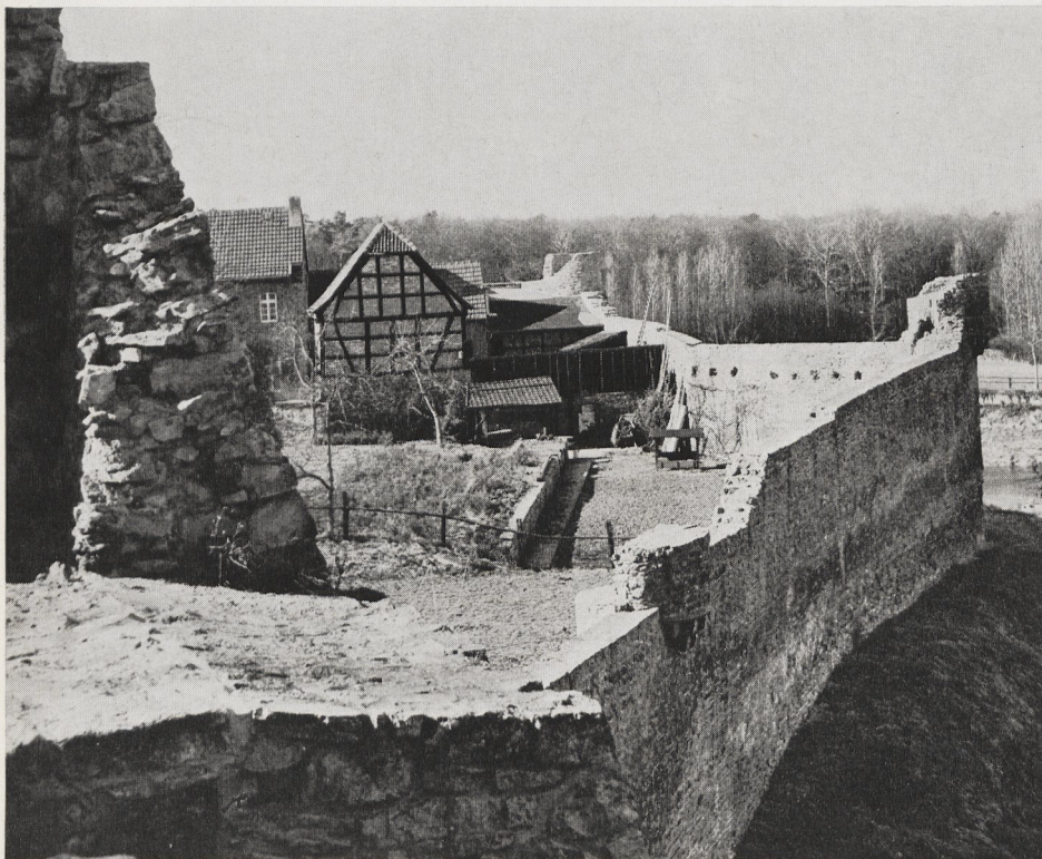
Abb. 10. Burgruine Hardtburg. Nordöstliche äußere Ringmauer mit Blick auf das ehemalige Amtshaus (Fachwerkaufbau auf massivem Erdgeschoß) aus kurfürstlicher Zeit
