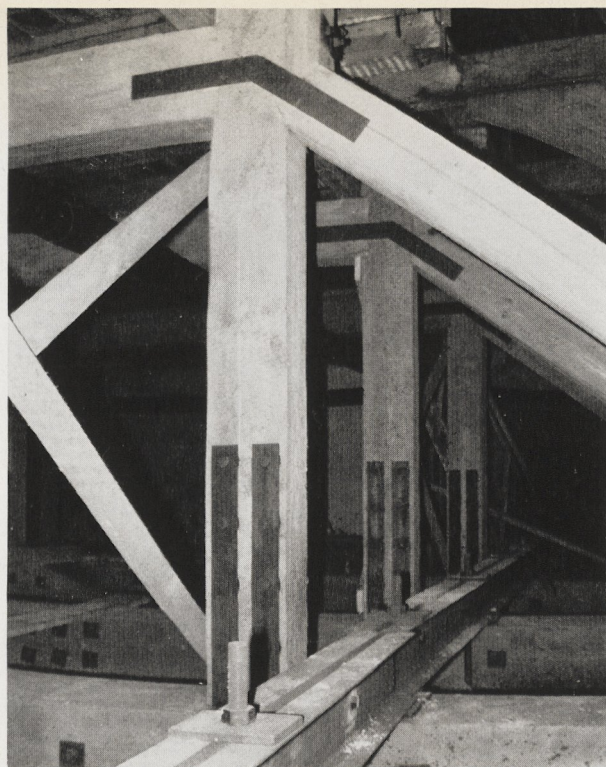
Abb. 3. Haus Vischering. Holzbinder-Tragwerkkonstruktion, an der die Holzbalkendecken des Erd- und Obergeschosses 1970 aufgehängt wurden. Foto: Verfasser
