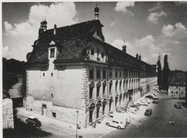
Abb. 3. Malteser-Hauptverwaltung Amberg, Schutz gegen aufsteigende Feuchtigkeit mit Aida KIESOL im Bohrlochverfahren
