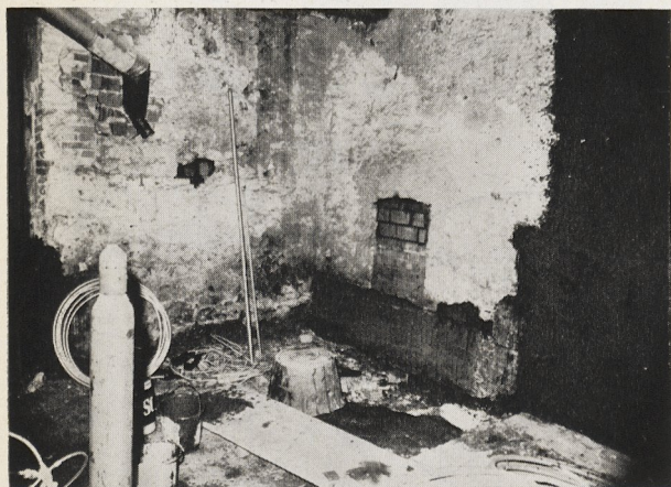
Abb. 2. Unterhaltungsarbeiten und Trockenlegung des Museums „Römerkastell Saalburg“ bei Bad Homburg
