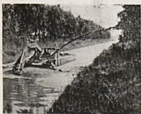
Bürstenkopf-Saugbagger mit Schlammauswurf oder mit schwimmenden Leitungen.
