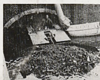
Kleine Schubboote baggern Gewölbe und Abzugskanäle.
