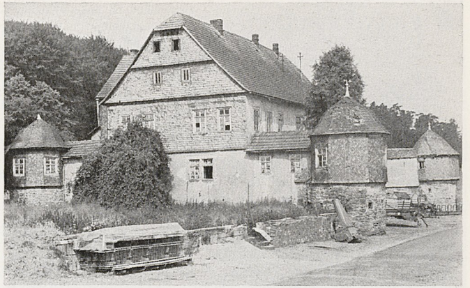
Der Schmitthof vor der Sanierung
