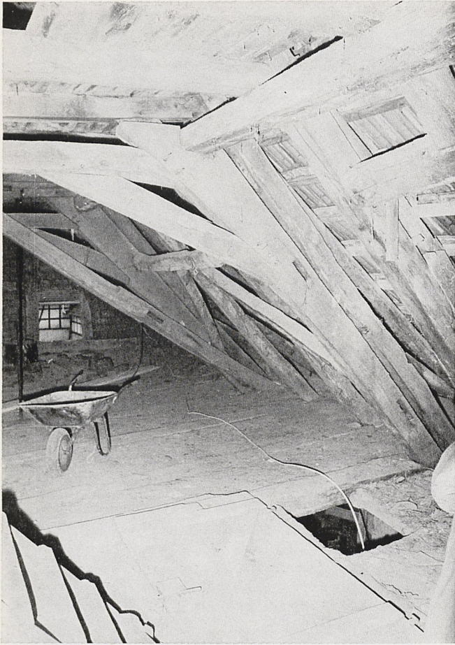
Dachgeschoß des Hauptgebäudes
