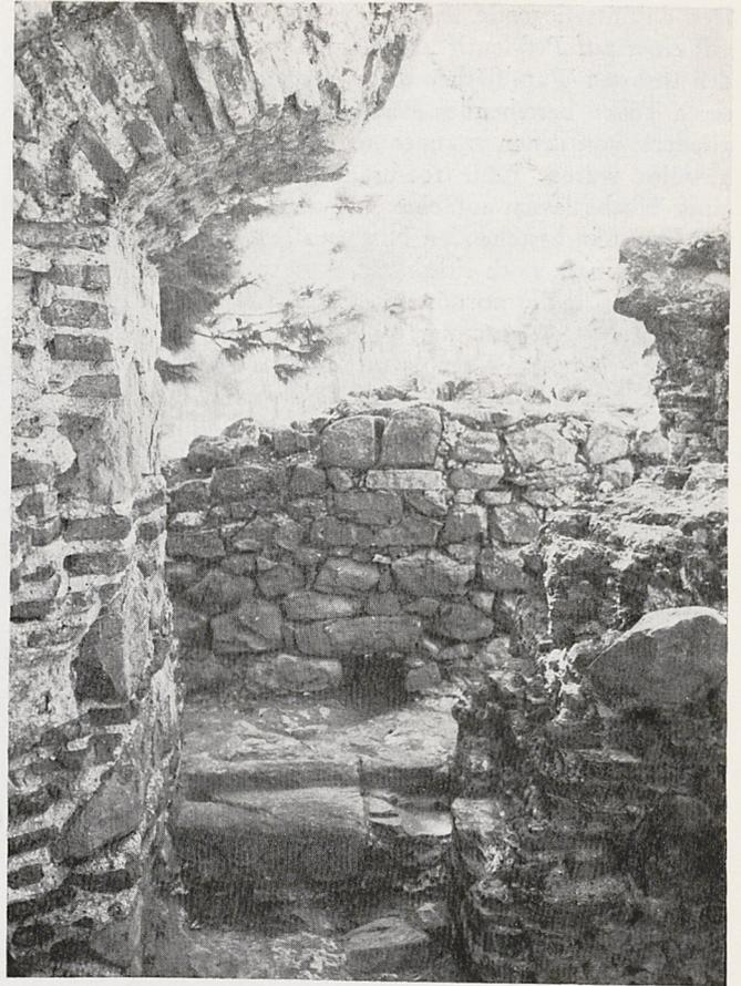
Abb. 8. Zugang in die obere Kammer des Flankierungsturmes. Im Vordergrund Türschwelle mit Anschlag und Zapfenloch, dahinter die Brustwehr der portugiesischen Periode.
