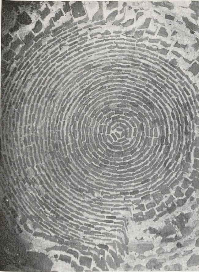
Abb. 7. Das Ziegelgewölbe in der unteren Kammer des Flankierungsturmes. Foto Redman 1980
