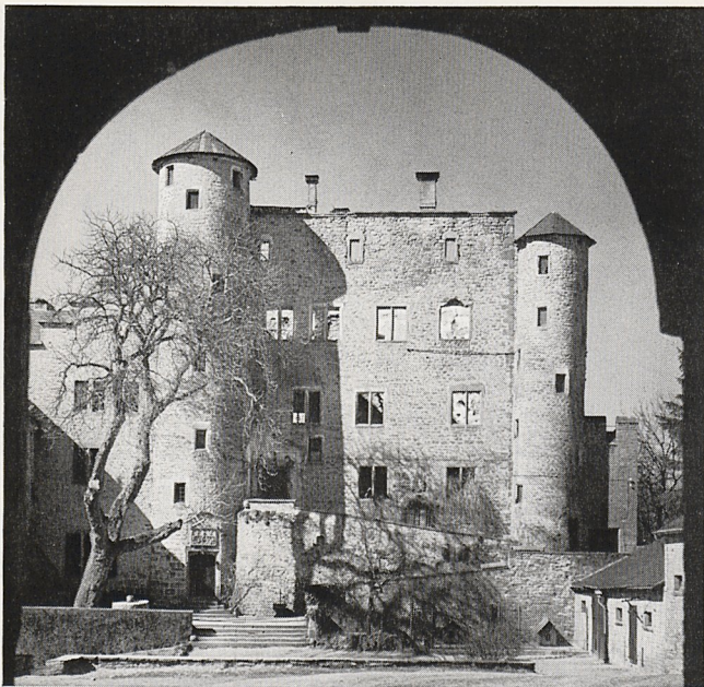
Abb. 4. Burg Hamm. Hofseite von Südwesten nach dem Brand 1945.
