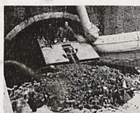
Kleine Schubboote baggern Gewölbe und Abzugskanäle.
