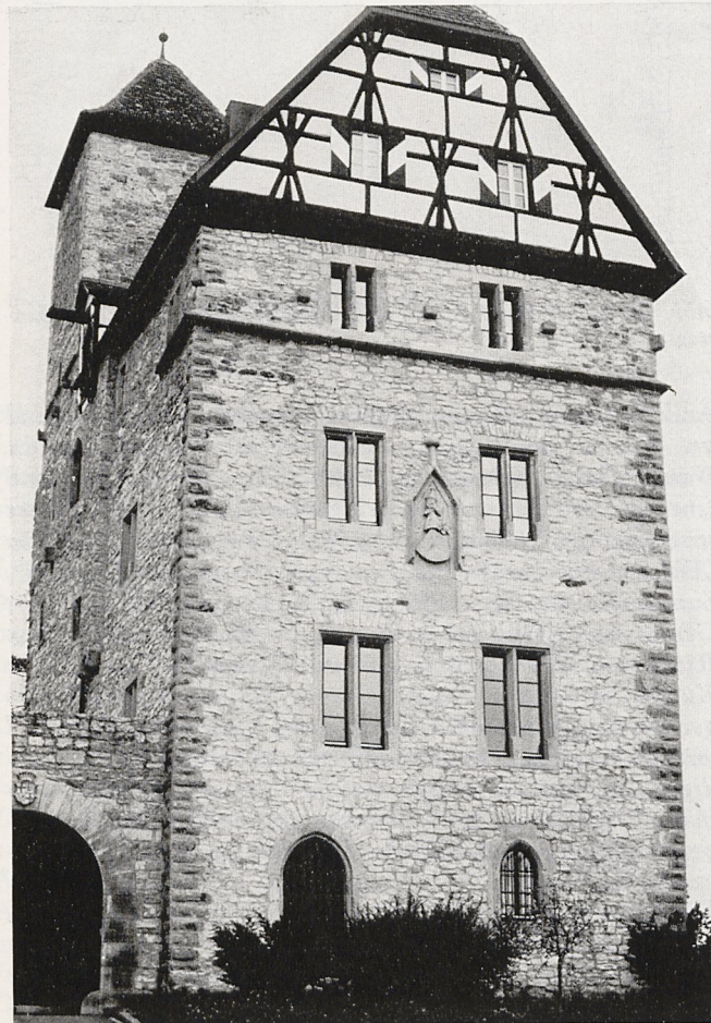
Abb. 16. Südseite. Zustand 1981. Bei der nach 1975 erfolgten Sanierung des Südgiebels wurden die dreiteiligen, gestuften Fenster von 1898 entfernt und durch zweiteilige ersetzt, sowie die Giebel Fenster vergrößert, wodurch ein erheblicher Reiz dieser Front verloren ging
