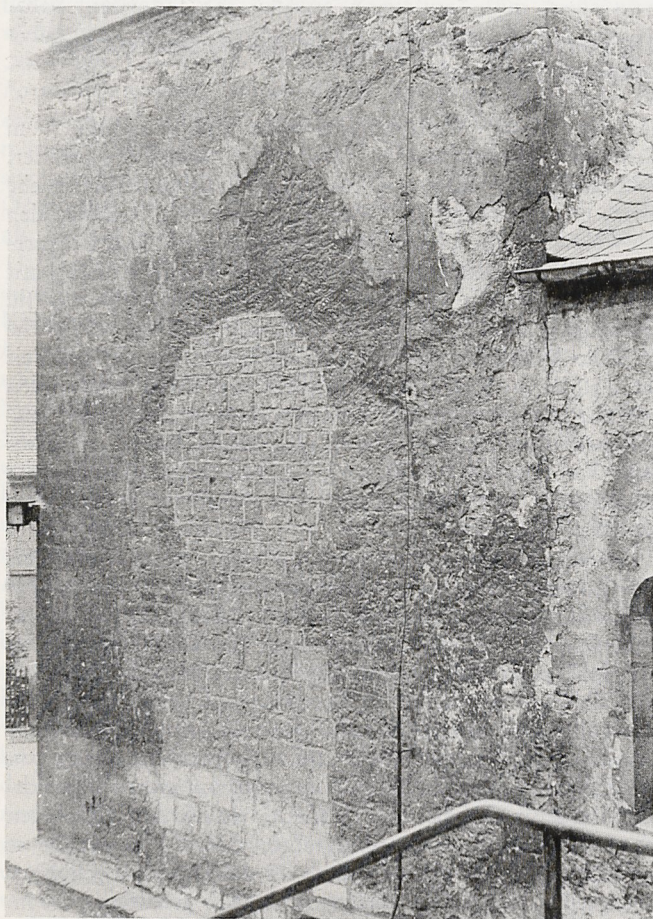
Abb. 8. Leutra, St. Johannis, Außenostwand des Chorrechteckes mit Spuren, die auf die Existenz einer ehemaligen Apsis hinweisen (Foto: H. Weinhold)
