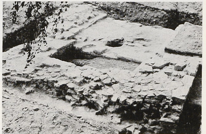
Abb. 20. Welje. Unterer Teil des Südostturms. Blick von Osten
