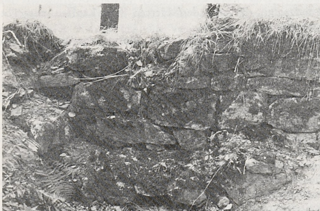
Abb. 4. Kronenburg-West, Grundmauern des Wohnturmes, Foto: G. Schröder
