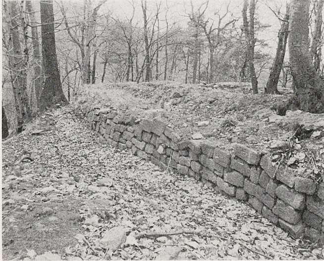
Abb. 2. Kronenburg-West, Südseite der Ringmauer, Foto: Steinmetz
