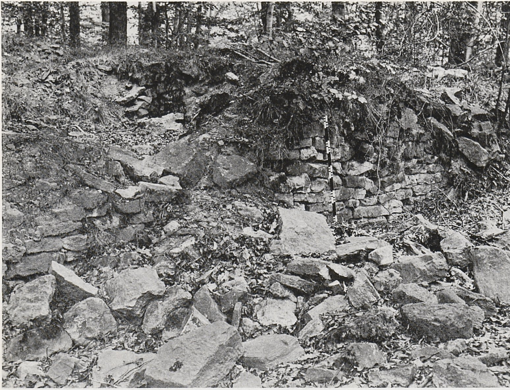
Abb. 8. Kronenburg-West, Mauerwerk des Turmes; Blick nach Südosten, Foto: Wenz
