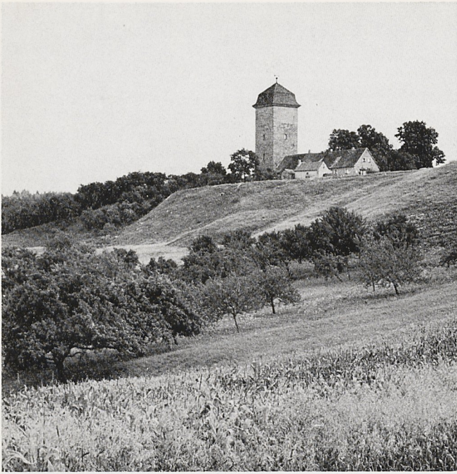
Abb. 8. Der alte Wasserturm mit Pumpen- und Brunnenwärterhaus über dem Nordhang des „First“, östlich von Schillingfürst. Der untere Teil des Wasserturmes von 1729, das obere Stockwerk aus Hausteinmauerwerk aufgesetzt 1887. Die Ochsentretscheiben-Pumpenmaschine im rechts (westlich) anschließenden (hier von den Stadeln verdeckten) Brunnenhaus von 1702. Foto: Verfasser
