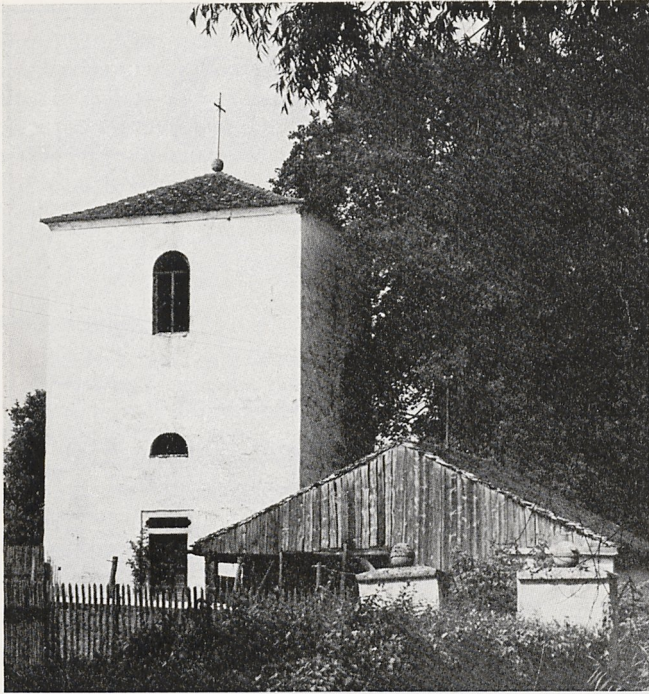
Abb. 17. Wasserturm von Schloß Schönbrunn von Osten. Foto: Verfasser
