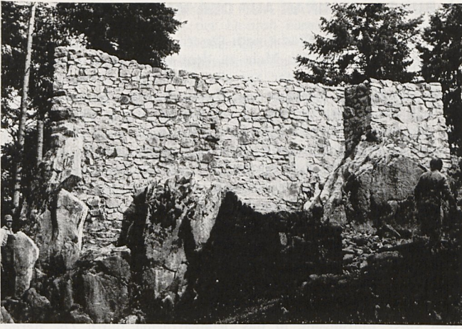
Burgruine Keppenbach, Ostseite mit Zisterne und „spitzem Eck“
