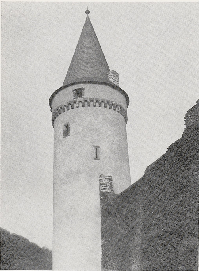
Abb. 8. Burg Vianden, sog. weißer Turm nach der Restaurierung (Herbst 1983)
