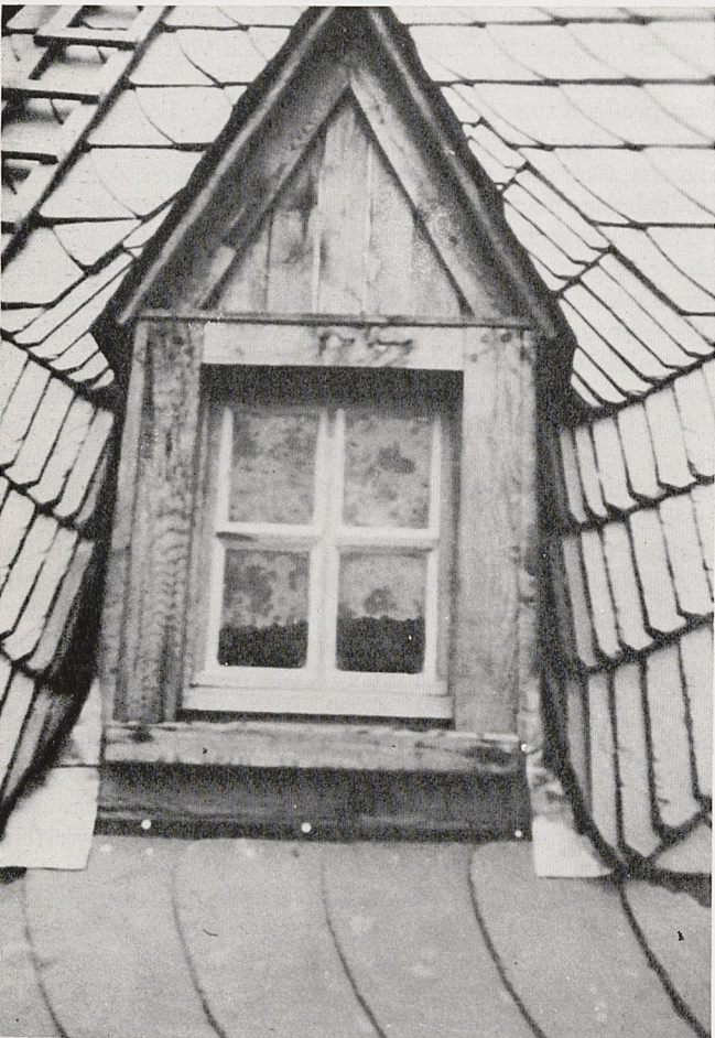
Abb. 9. Burg Vianden, Ausbildung der Dachfenster nach der Restaurierung (Herbst 1983)
