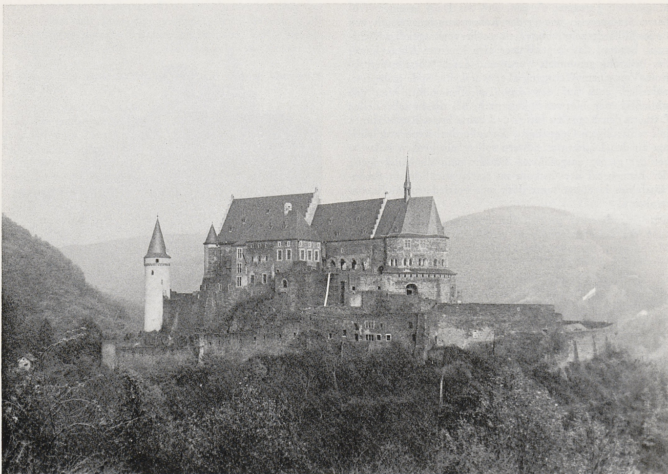
Abb. 5. Burg Vianden von Westen. Zustand Herbst 1983
