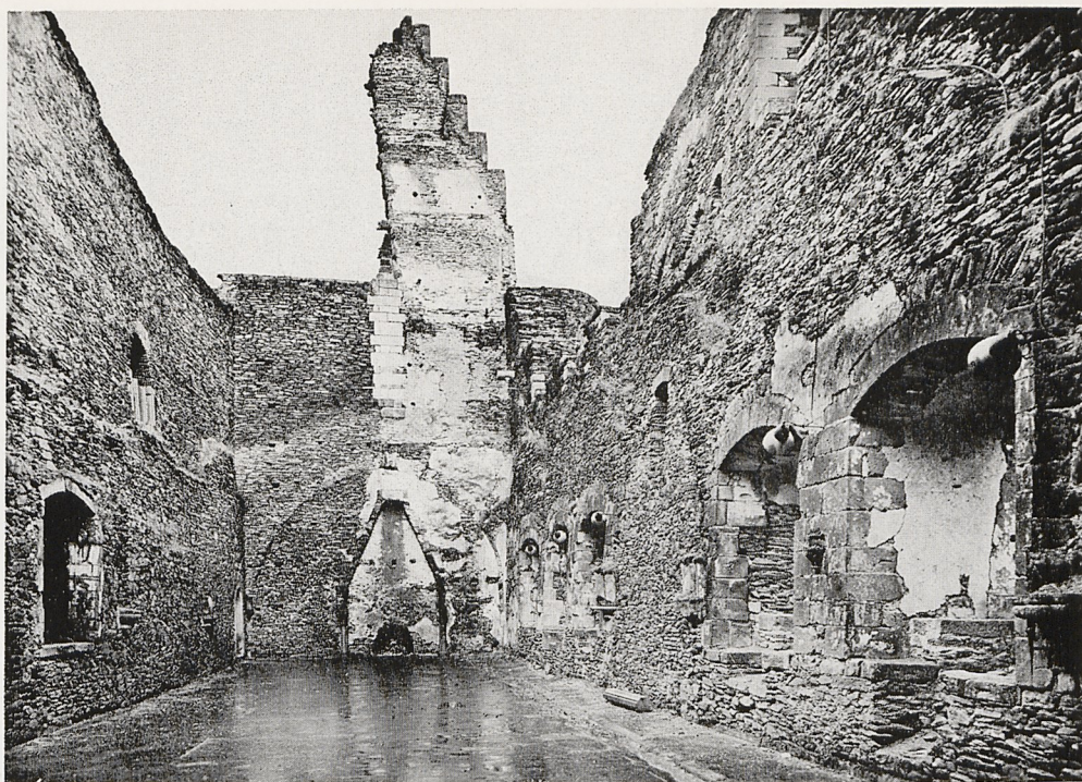
Abb. 10. Burg Vianden, Großer Palas vor der Restaurierung. Foto: Landesamt für Denkmalpflege Rheinland-Pfalz (1962)
