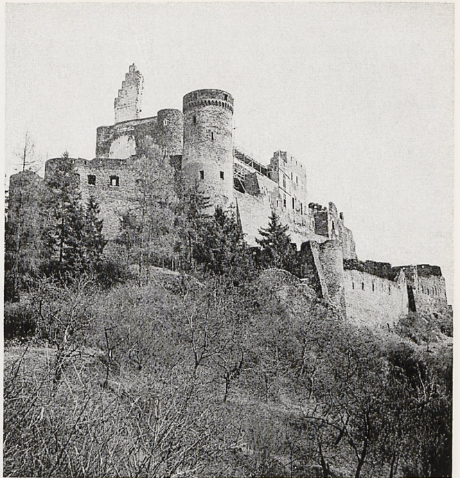
Abb. 3. Burg Vianden vor der Restaurierung, Blick von Osten. Foto: K. Willkomm, DBV-Archiv
