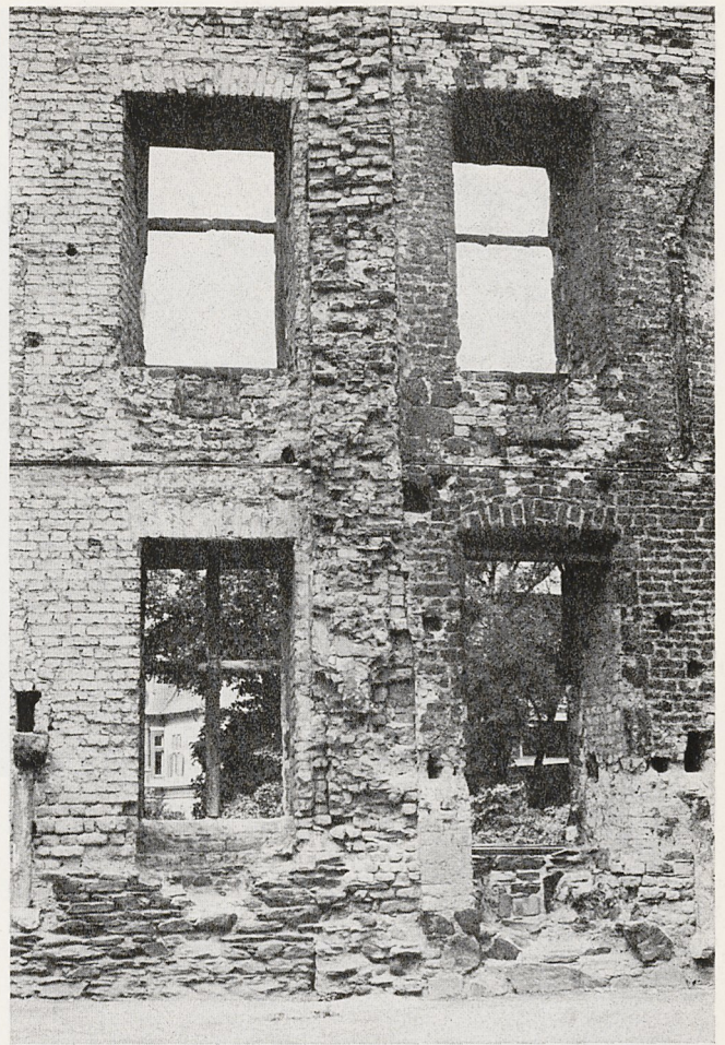
Abb. 17. Abbruchkante der Quermauer zwischen Palas A und B. (Photo U. Wirtler, 1983)
