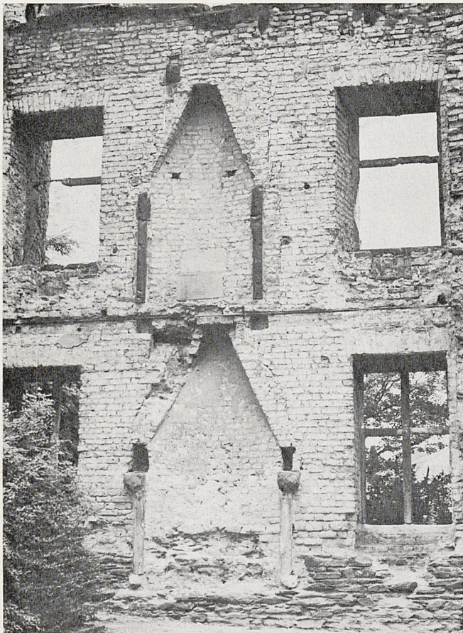
Abb. 16. Palas B. Innenansicht der westlichen Langseite. (Photo U. Wirtler, 1983)
