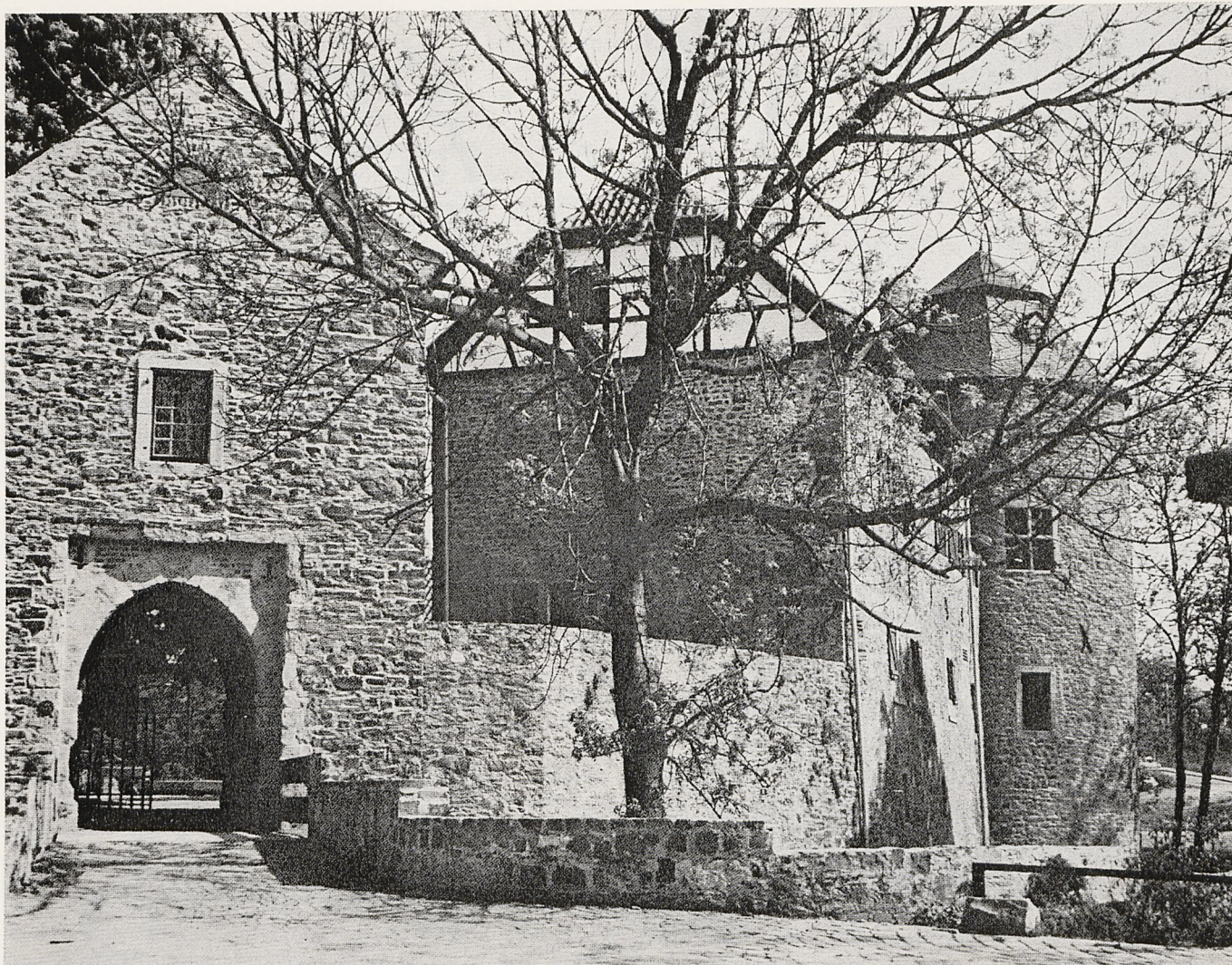
Abb. 1. Torturm mit wiederhergestellter Zugbrücke, Herrenhaus und Südwestturm.
