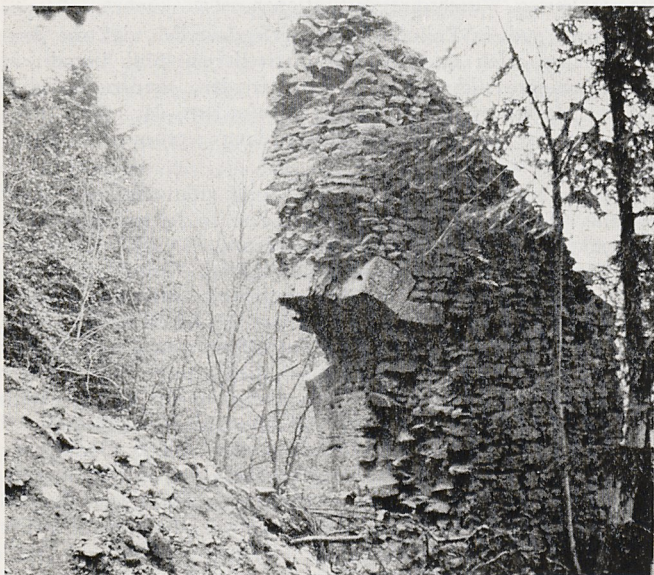
Abb. 1. Ruine Wieladingen, Einsturzstelle 1983
