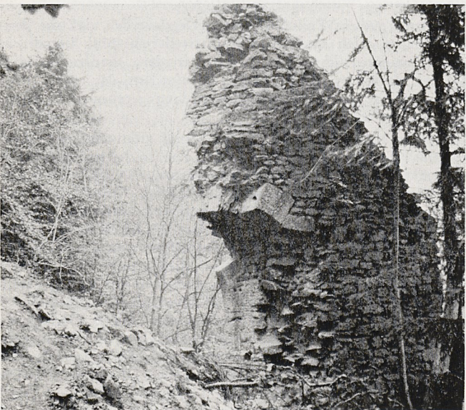
Abb. 1. Ruine Wieladingen, Einsturzstelle 1983
