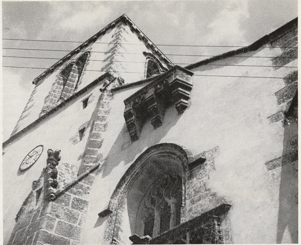
Abb. 1. Saint-Pierre-de-Chemin, Gußerker über dem Westportal. Foto: K. Kafka
