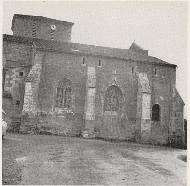
Abb. 10. Thieré, Schießscharten unter dem Dachrand. Foto: K. Kafka
