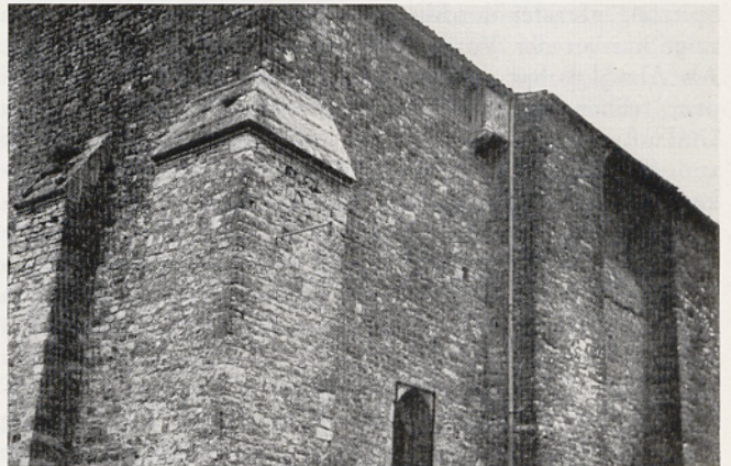
Abb. 12. Saint-Juire-Champgillon, Gußkerker über vermauerter Nebenpforte. Foto: K. Kafka
