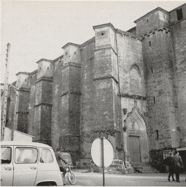
Abb. 9. Cheffois, Befestigung durch Strebepfeilertürmchen. Foto: K. Kafka
