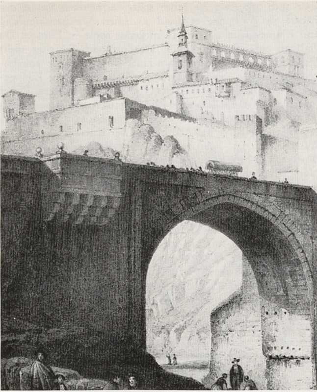
Abb. 6. Der Alcázar in Toledo von Nordosten (Ausschnitt aus einer Lithographie von etwa 1850). Das Bauwerk damals eine Brandruine. An der Ostfront (im Bilde links) bezeichnen die Wehrgangskonsolen (Bauzeit um 1255) etwa die Höhe der damaligen Außenwände; was darüber sichtbar ist, wurde im 16. Jh. gebaut
